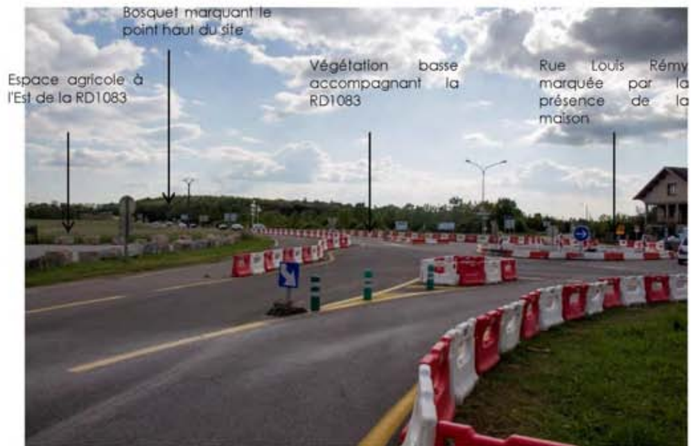
Vue du site depuis l'intersection entre la RD159 et la RD1083
