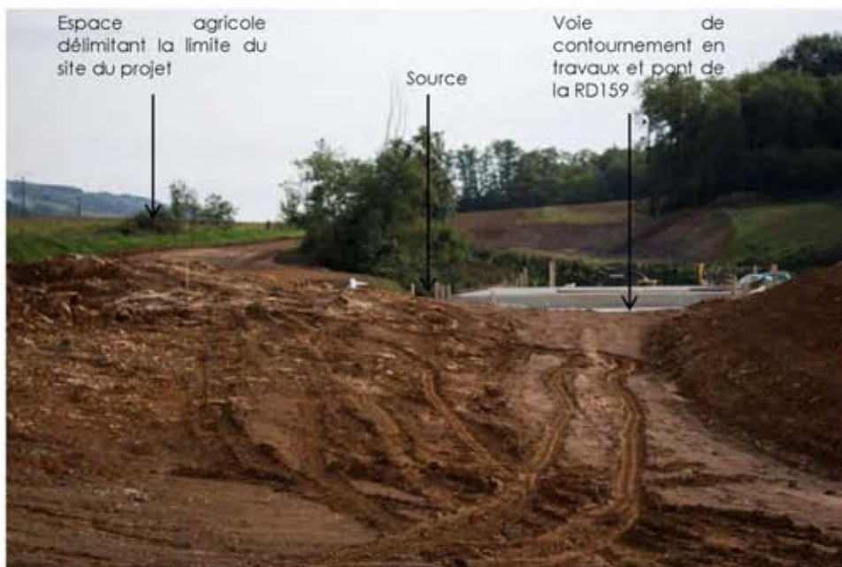
Vue de la frange Ouest du site depuis la voie de contournement Ouest de Lons le Saunier en direction de Bourg en Bresse
