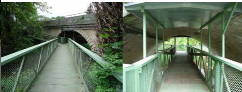
Passage sous la départementale et sur la Sorne
