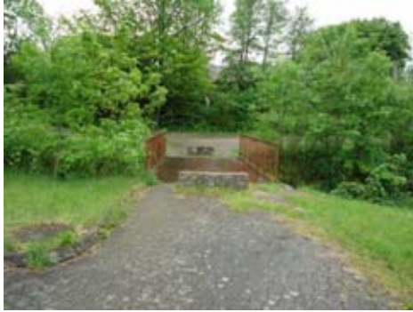
Pont sur la Sorne
