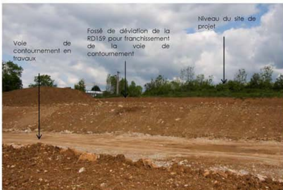
Vue du site en surplomb de la voie de contournement
