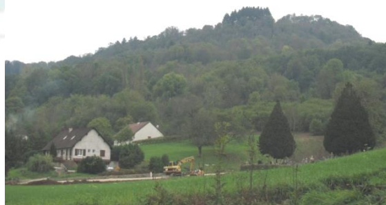
Constructions intermédiaires le long de la RD41 à l'entrée du village
