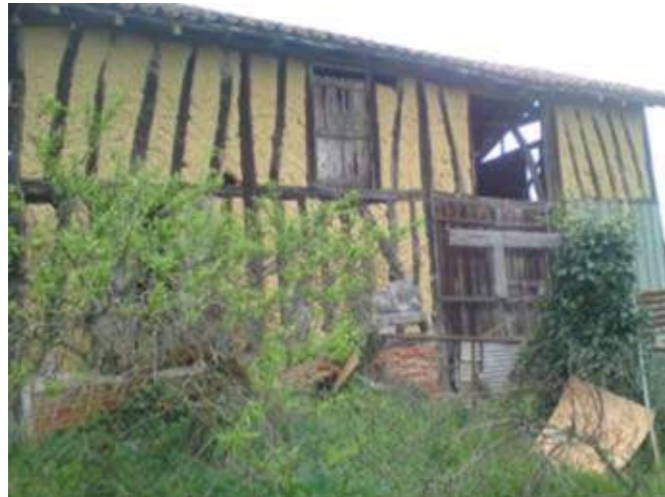
CONSTRUCTION N°12 : SECTEUR TAMARIN
