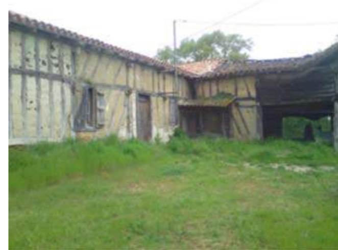
CONSTRUCTION N°8 : SECTEUR LABAURE
