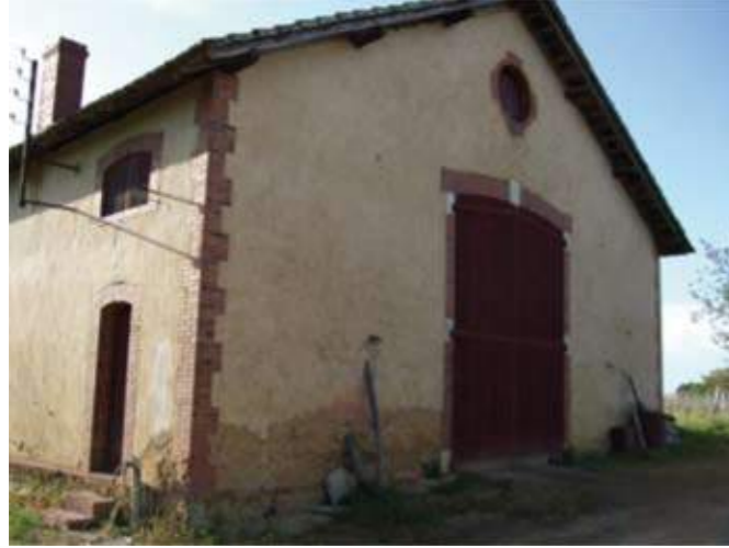
CONSTRUCTION N°10 : SECTEUR TOUPIE
