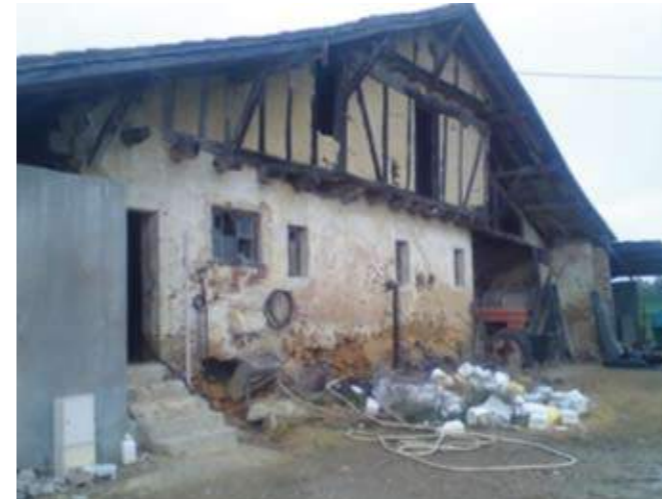
CONSTRUCTION N°9 : SECTEUR LAHITAU
