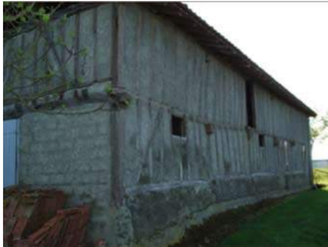
CONSTRUCTION N°5 : SECTEUR RIBERE
