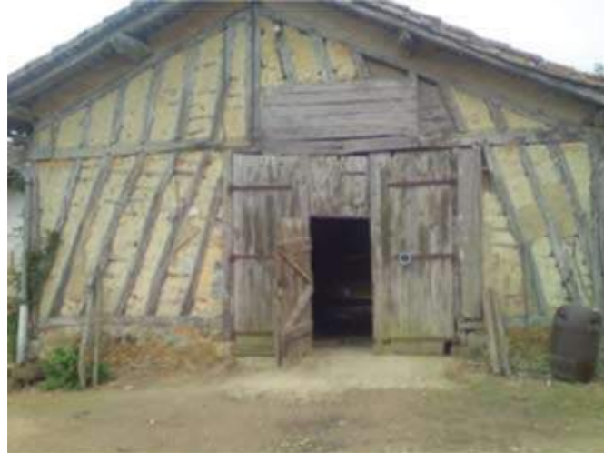
CONSTRUCTION N°11 : SECTEUR CULPET
