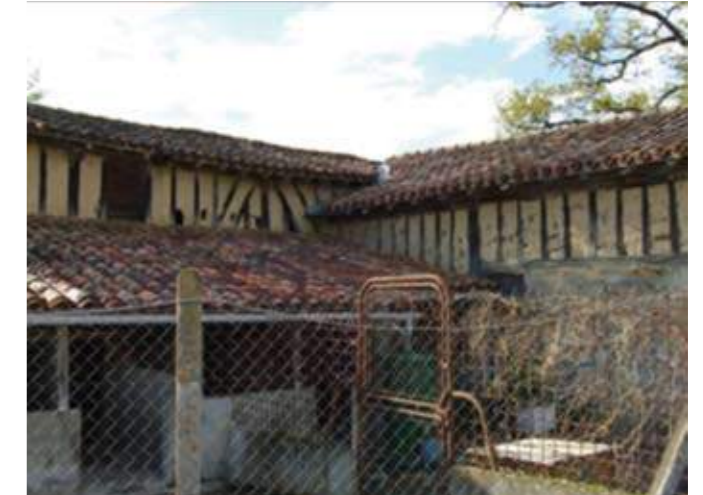
CONSTRUCTION N°2 : SECTEUR BERNICOT
