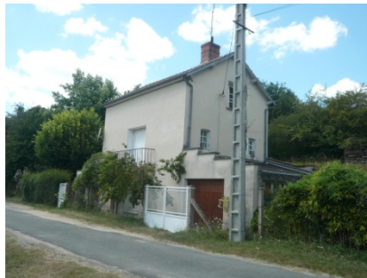
9. La Pêcherie : maison éclusière sur le canal de Berry
