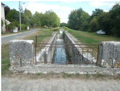
8. La Pêcherie : écluse du canal de Berry
