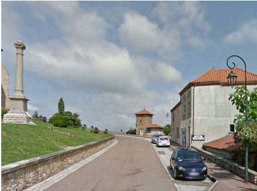
Place de stationnement le long des voies dans le centre bourg
