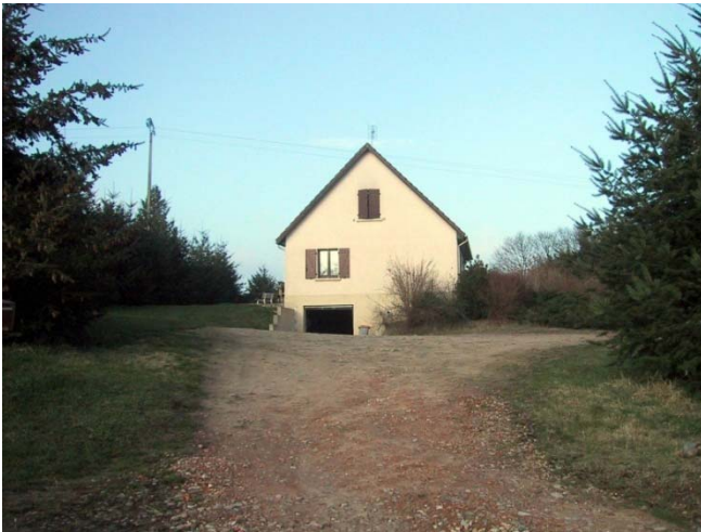
Maison de Maltaverne de type normand avec une toiture très pentue.
