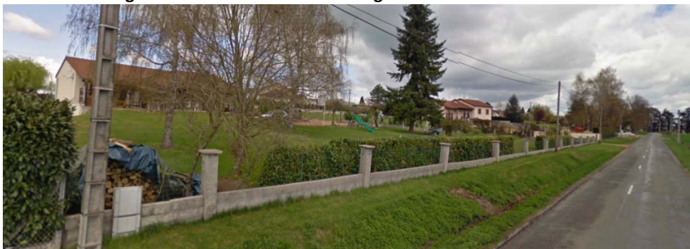
Vue depuis la route de Melay sur l'urbanisation linéaire du hameau les Sables.
