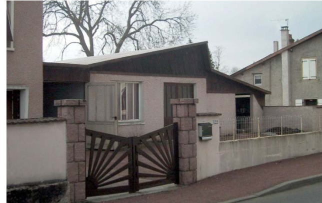
Bâtiment réhabilité en garage. Ce volume est synonyme de l'ère industrielle, ouvrière avec cette toiture caractéristique.
