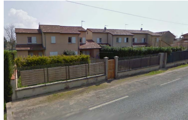
Logements locatifs le long de la RD 43 rappelant les « cités » ouvrières (volume longitudinale, symétrie des travées). Cependant, le volume reste surchargé (décrochement de façades, présence d'avant-toit).
