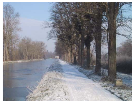
< Alignement d'acacias le long du chemin de halage et de la servitude de marche pied.
