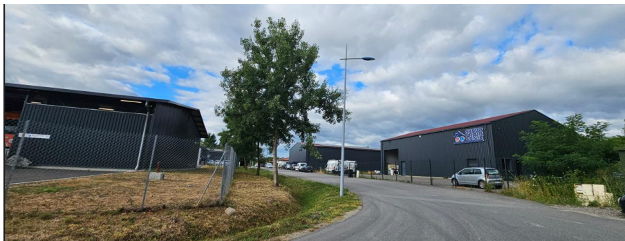
1. Vue depuis l'entrée de la zone d'activités
