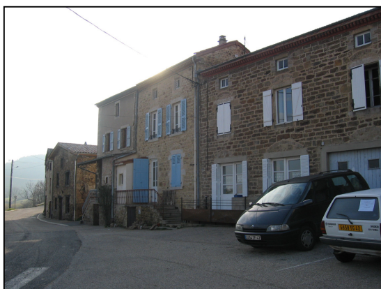
Le front bâti, structure de la place
