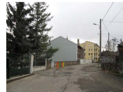
Rue Joannes Mourier : une requalification de la voirie sera nécessaire
