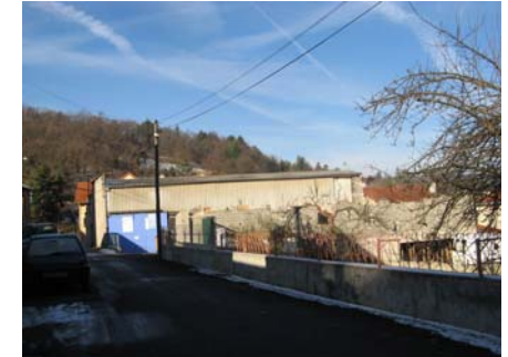
Bâtiment d'activités rue Jean Macé
