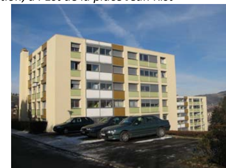
Cité du Bourg : constructions des années 60 Toiture terrasse, hauteur importante, bon état
