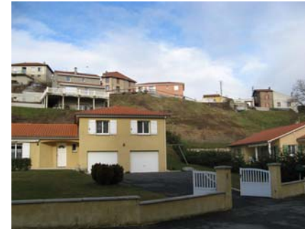
Vue depuis la rue Mozart : constructions plus récentes, sur un secteur plus pentu nécessitant des mouvements de terrain importants.
