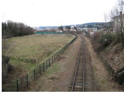
La voie ferrée
