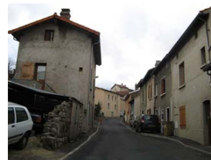
Rue Gabriel Péri : constructions à l'alignement, problème de stationnement
