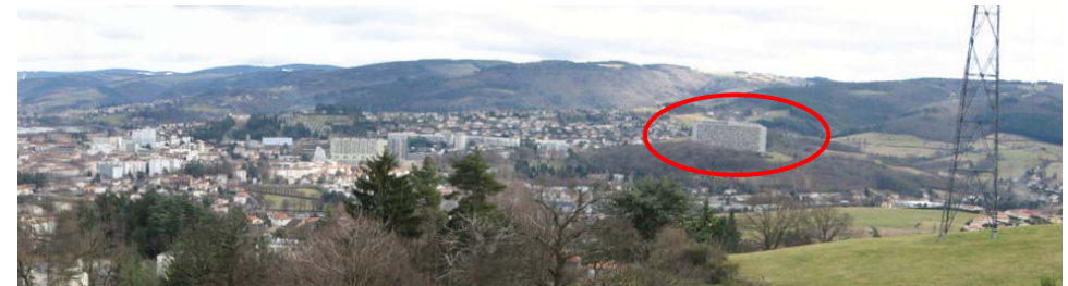
Unité d'habitation vue depuis le Pin
