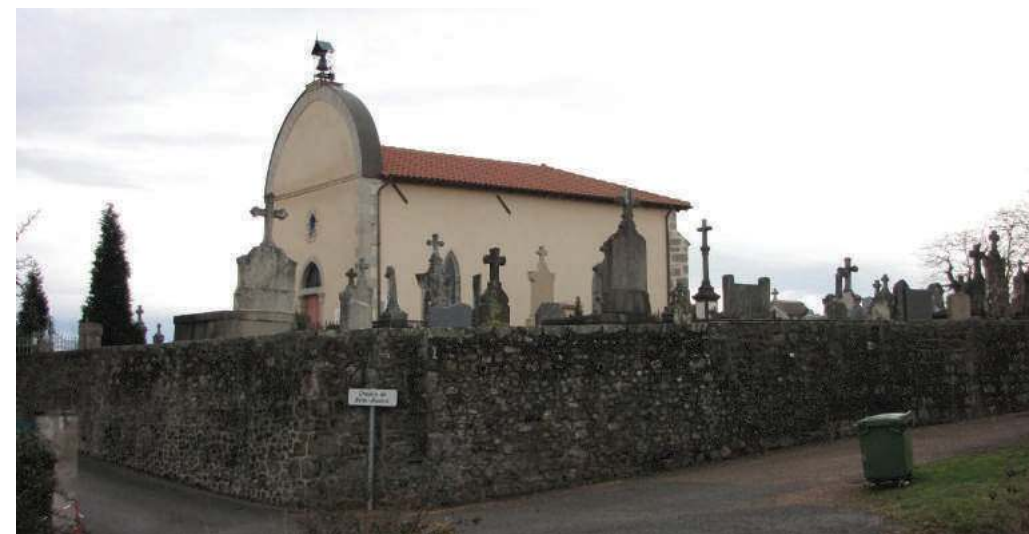
3- Tourzy, chapelle bâtiment remarquable parcelle 201 et murs de clôture parcelle 202
