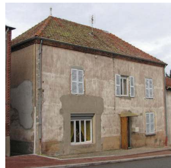
9- La Gare, bâtiment caractéristique parcelle 45
