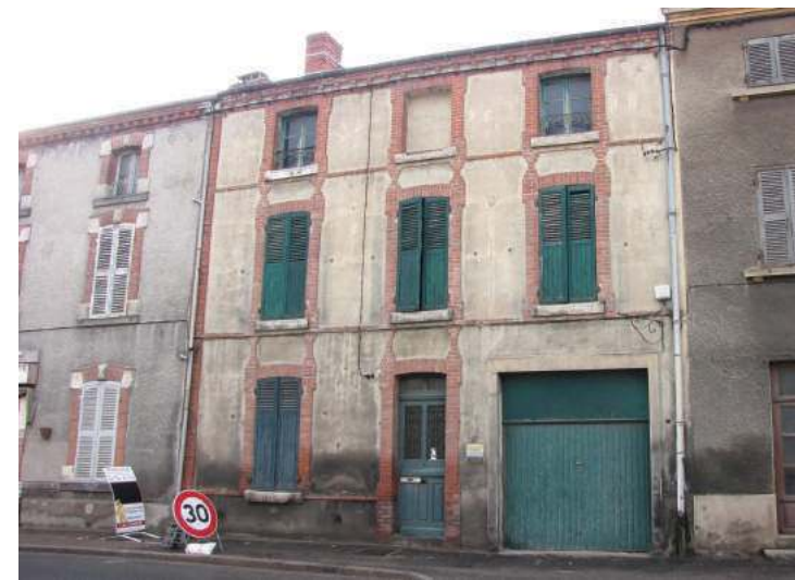
6- Ensemble des bâtiments marquant l'entrée du centre bourg, bâtiment caractéristique parcelles 46, 47, 50 51, 53 et 54.
