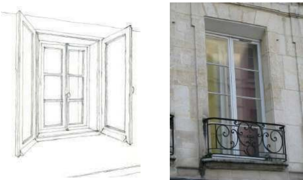
Exemple de doubles-fenêtres, vues de l’intérieur et de l’extérieur
