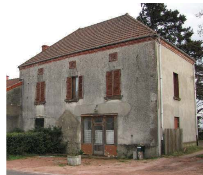
10- La Gare, bâtiment caractéristique parcelle 405
