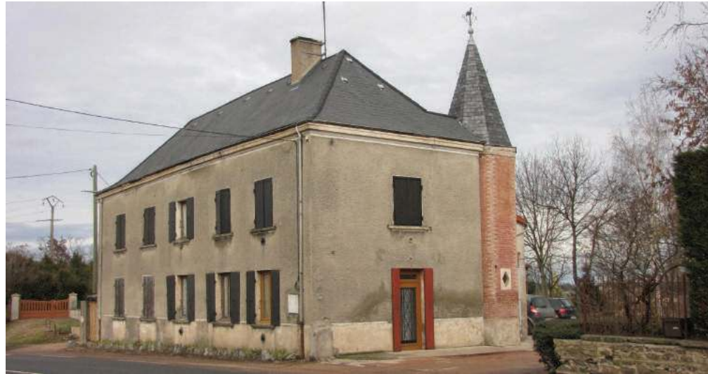
1- La Vallette Sud, bâtiment caractéristique + détail remarquable tourelle parcelle 421
