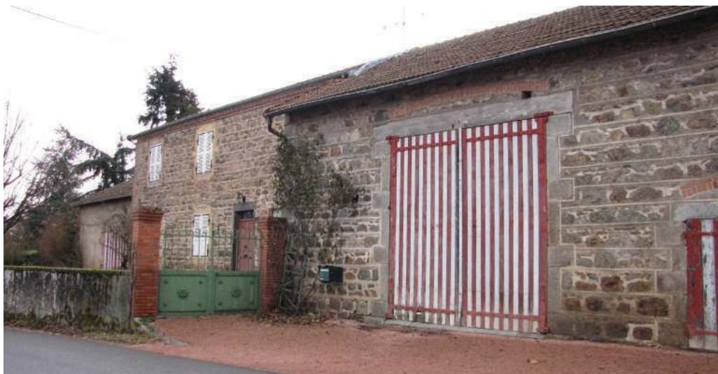
12- La Gare, bâtiment caractéristique parcelle 37
