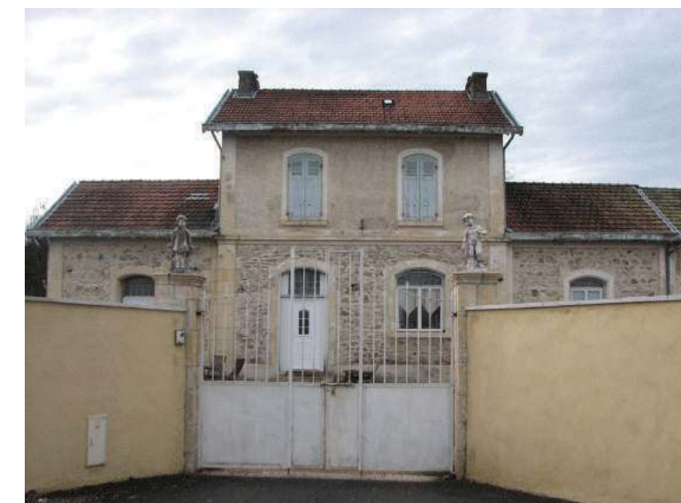
11- La Gare, bâtiment caractéristique parcelle 564
