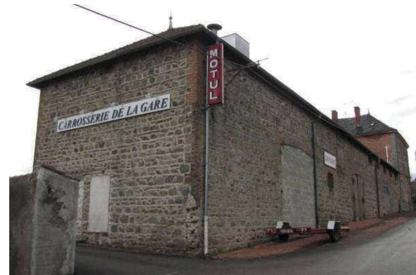
3- La Gare, bâtiment caractéristique parcelle 437
