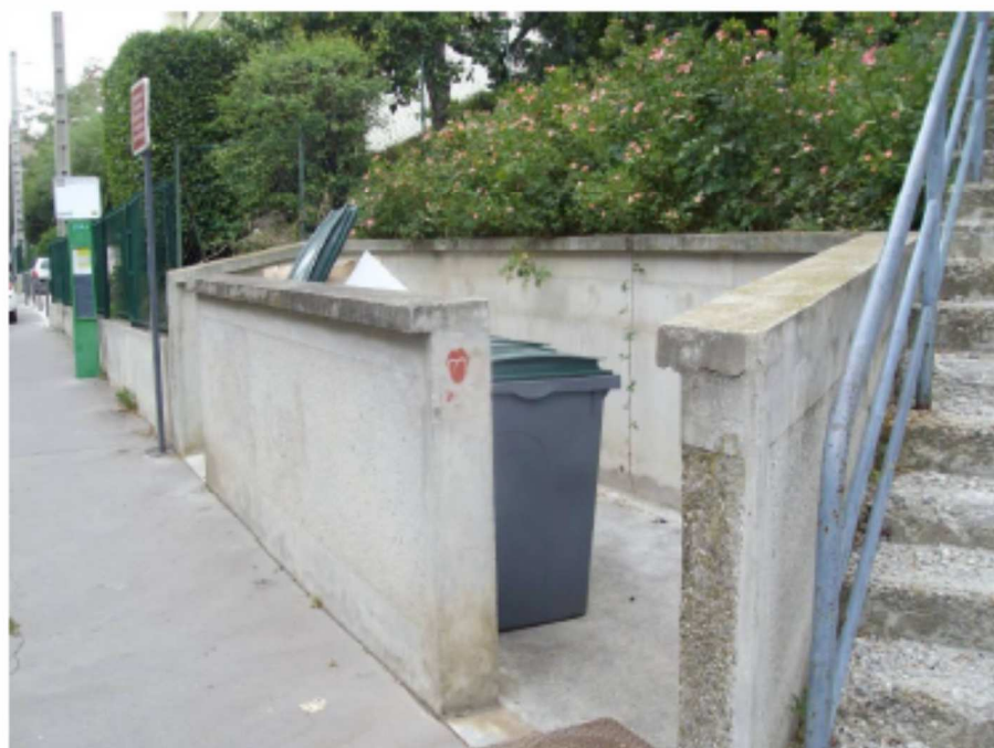
Dalle béton + mur
