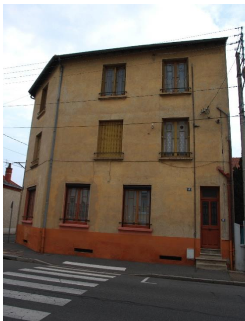
Exemple d'un édifice pouvant supporter une isolation par l'extérieur : pas de modénature et présence d'un recul par rapport aux façades latérales.
