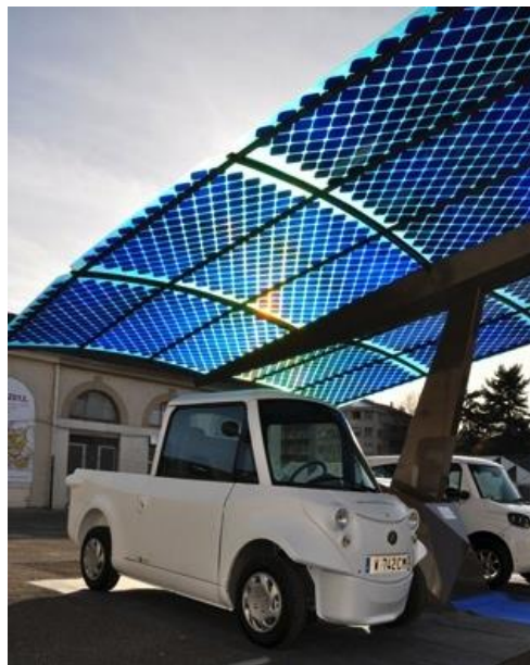
Ombrière photovoltaïque sur un parking Source internet
