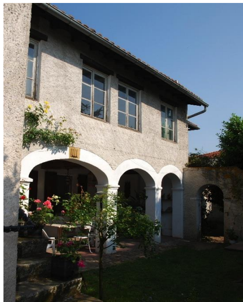
La ferme du Pontet
