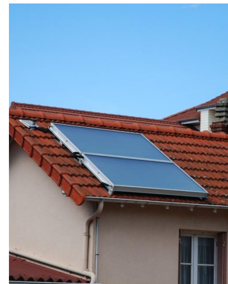
Panneaux solaires photovoltaïques permettant la production d'électricité reversée au réseau EDF
