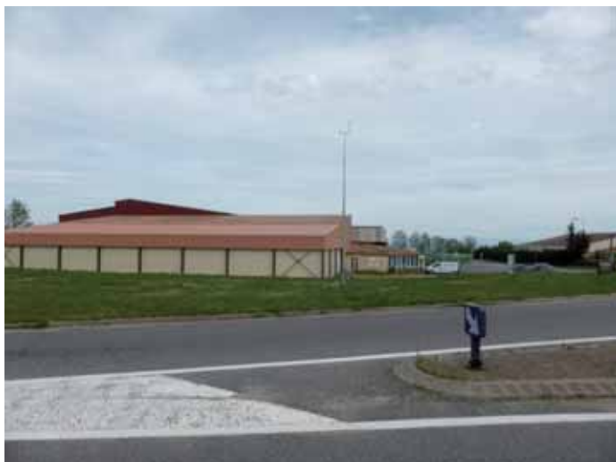
Coopérative des balcons du Pilat (Bessey)
