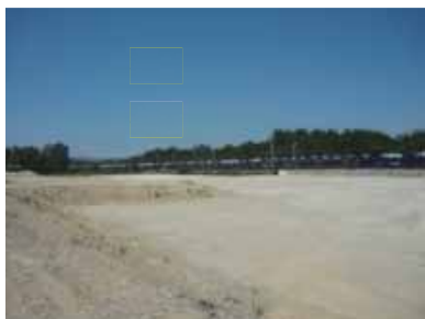
Le site de La Bascule à Saint Pierre de Bœuf
