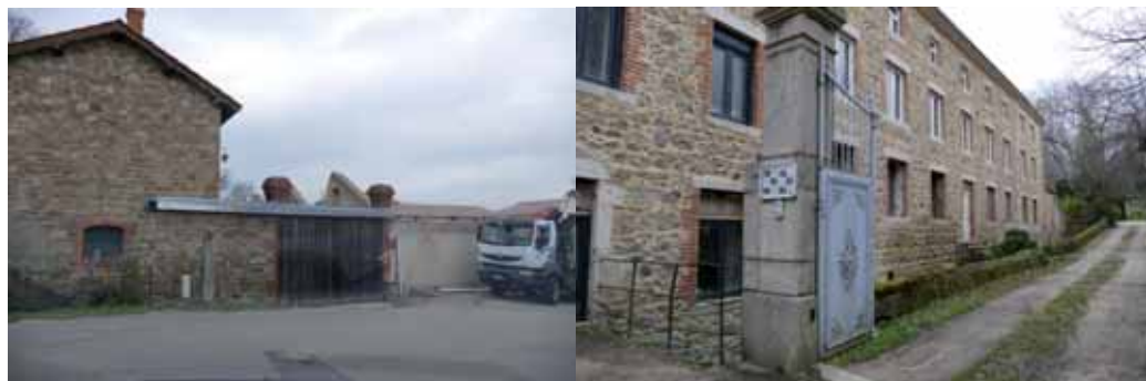
Ancienne usine/atelier du Briat
