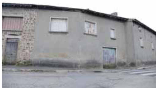
Logement vacant à l'entrée du bourg de Roisey
