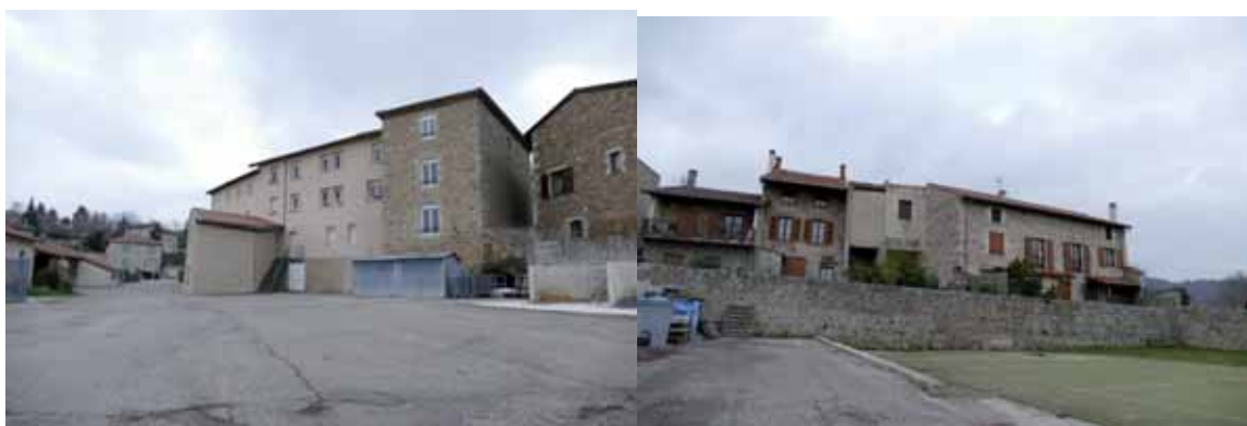
A gauche : Espace en face de l'école (vers la cantine et chaufferie bois) à requalifier, A droite : ancien terrain de tennis
