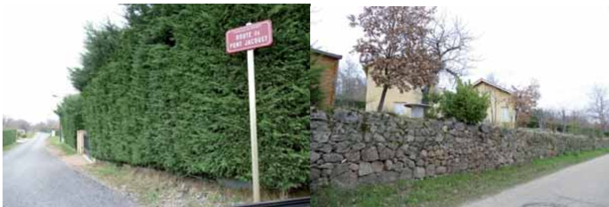
A gauche : la route du Pont Jacquet menant du bourg au hameau de Briat déqualifiée par le traitement des clôtures A droite : mur en pierre sèche conservé sur une parcelle pavillonnaire
