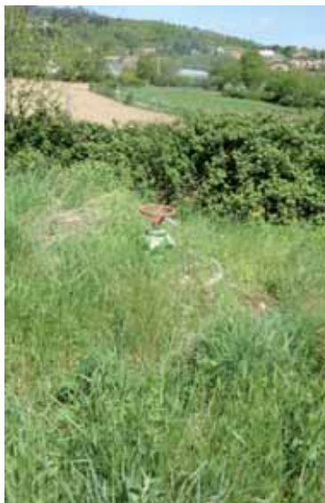
Borne d'irrigation au réseau
