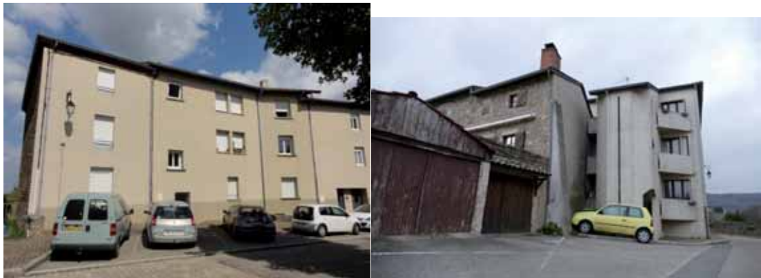
Logements sociaux à Roisey (à droite : opération « la porte ouverte » 2007, à gauche 3 logements au bourg de 1984)
