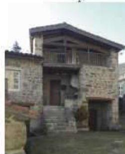
Exemple de débord de toiture
