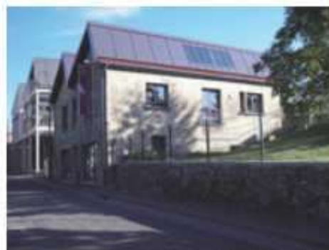
Exemple de toiture en shed
