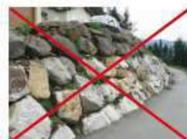
Exemple d'enrochements de type cyclopéen
