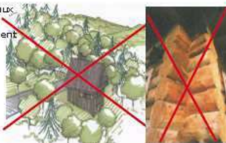
Exemple de construction de type «chalets» et madriers à assemblage croisé
