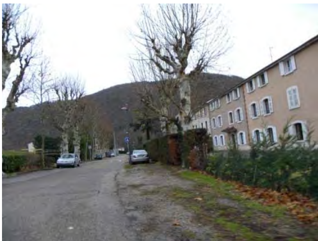
Logements sociaux de la teinturerie
