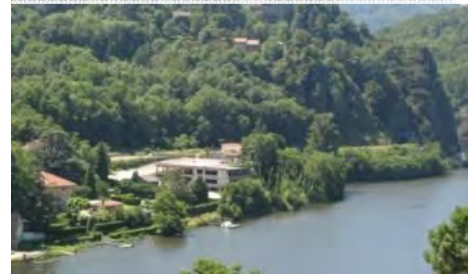
Un relief qui s'adoucit, permettant l'urbanisation
