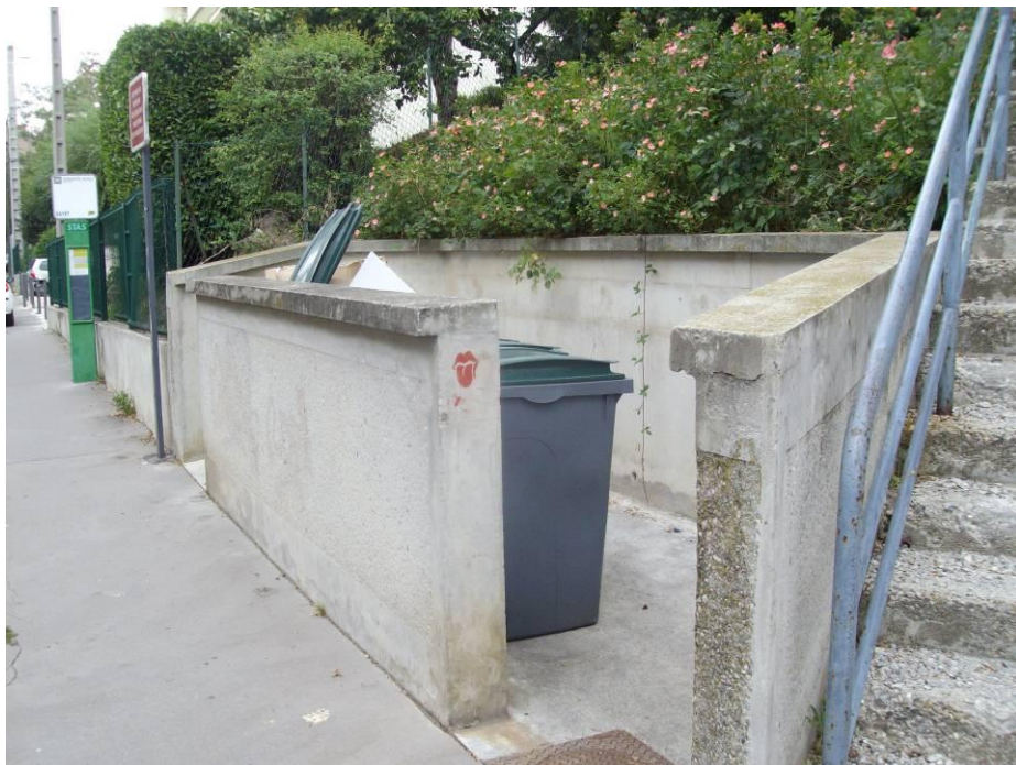
Dalle béton + mur
