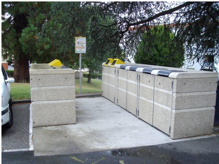
Abri préfabriqué + dalle + panneau de consignes
