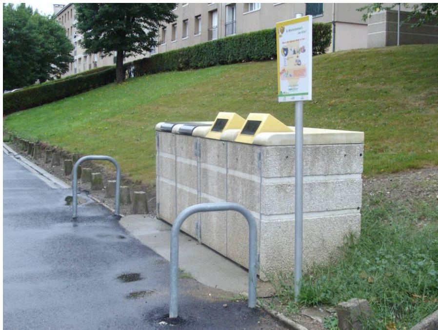
Abri préfabriqué + dalle + panneau de consignes + dispositif anti stationnement
