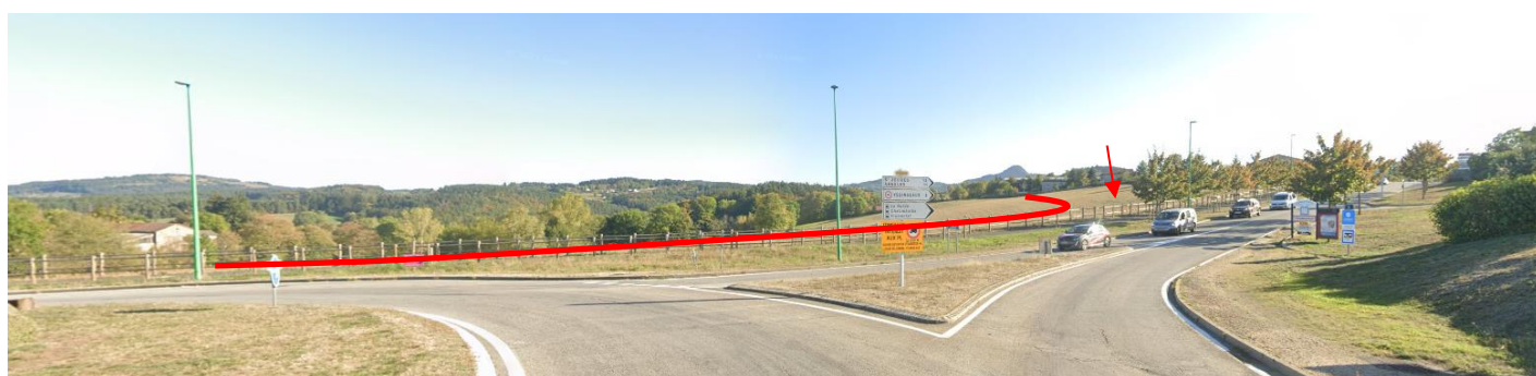
Vue vers les sucs du giratoire de la bretelle de la RN88 et du giratoire de la D105
