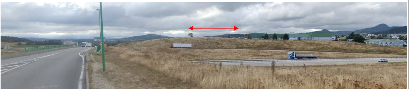
Vue de l'échangeur au nord-ouest RD105 (passage supérieur de la RN88)
