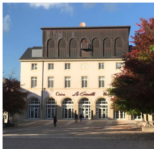
Figure 58 : Cinéma-Médiathèque La Grenette
