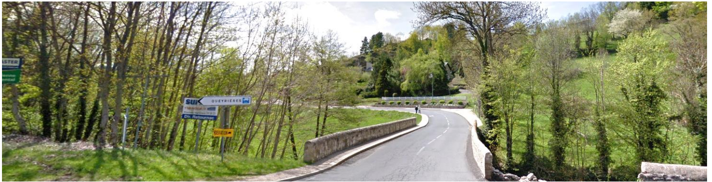
Figure 99 : Traversée de la Siaulme depuis la RD103
