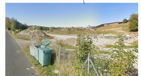
Zone de stockage - dépôt de matériaux
