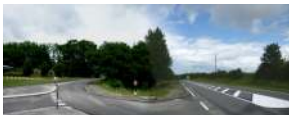
Panoramique 10 : ceinture verte en périphérie immédiate du centre bourg (urbanisation totalement dissimulée).
