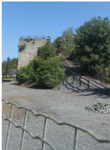
Erbray : Four à chaux
