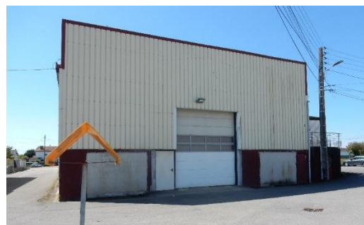
Vue sur les bâtiments de la friche
