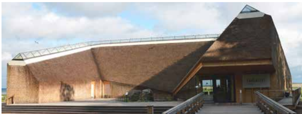
Naturum (Centre de visiteurs) sur les berges du sanctuaire pour oiseaux du lac Takern en Suède, réalisé par Jonas Edblad architecte. Le roseau local a été employé pour former ce bâtiment aux lignes futuristes.
