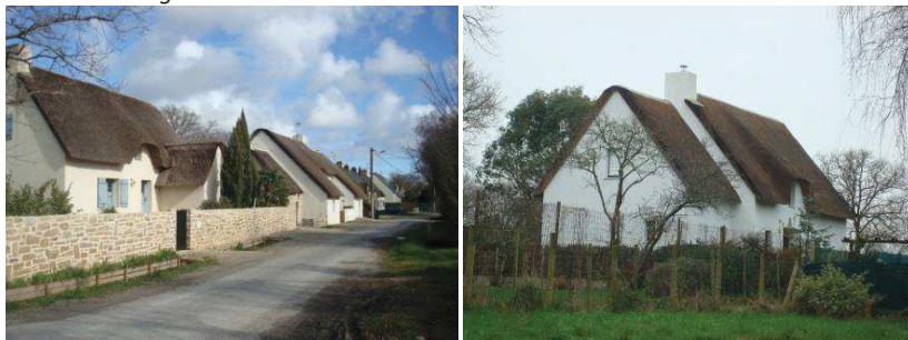
Des constructions contemporaines aux toits de chaume
