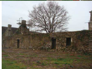
Arbours - Rénovation et extensions des chaumières dans les hameaux
