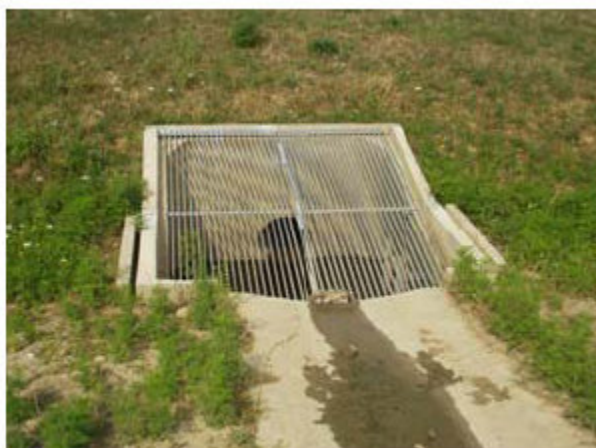
Grille de protection sur ouvrage de sortie
