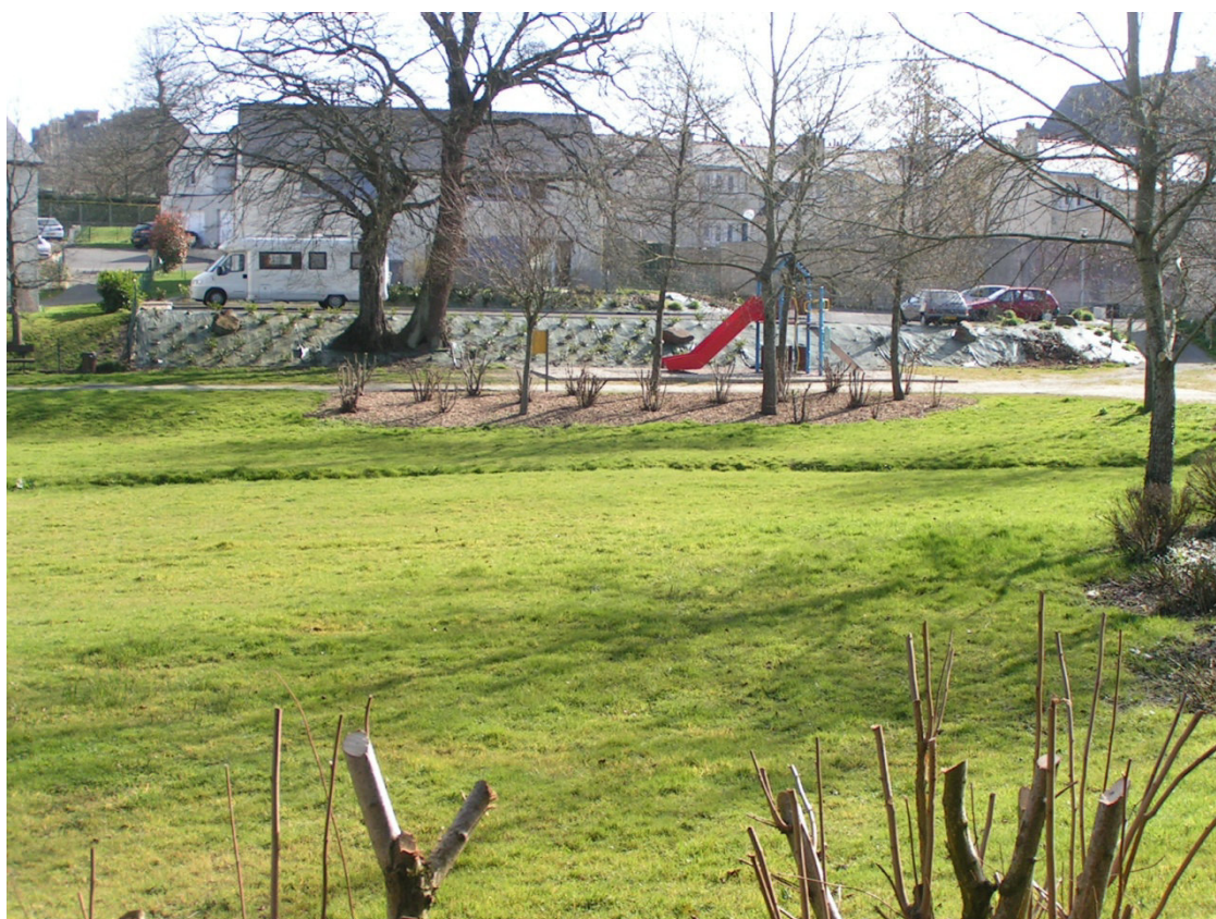
Photo 5 : Ouvrage double fonction : aire de jeux et bassin à sec
