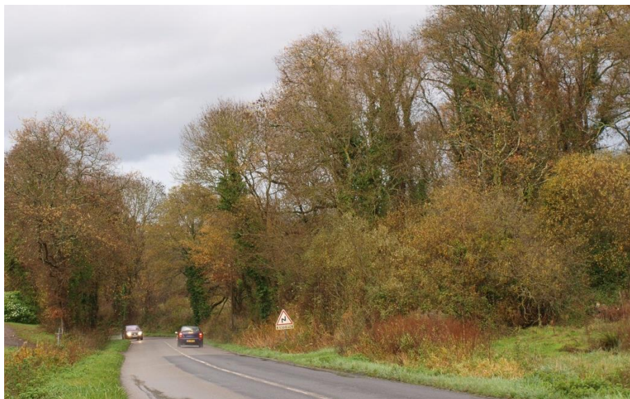
RD 74 s'insérant dans le paysage de fond de vallée : effet de tunnel végétal
