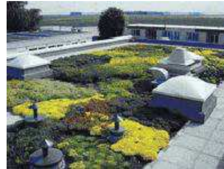
Stationnement engazonné à Libercourt (62)
