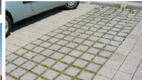
Stationnement en pavés non jointifs à Freiburg (Allemagne)
