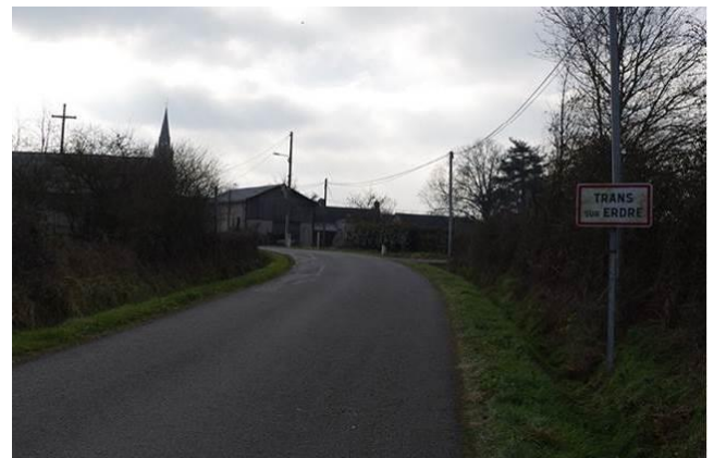
4 - Entrée Nord : l'entrée la plus rurale, venant du Nord par Mézay. C'est une entrée plus anecdotique.
