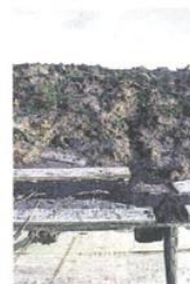
Détail d'une toiture végétale
