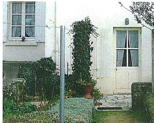
Porte simple, vitrée à quatre carreaux, avec allège à panneaux simples. Un panneau de volet amovible, ou un grand volet battant, sont possibles.
