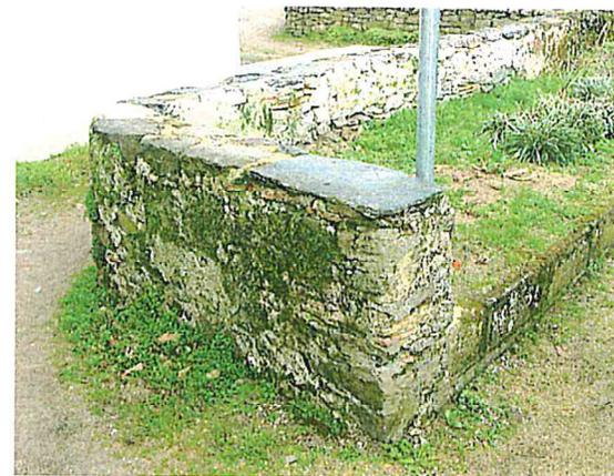
Exemple de murs en schiste originellement enduits, avec revêtement en dalles d'ardoise.
