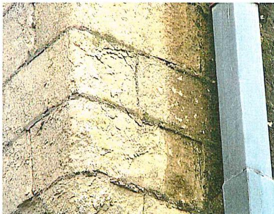
Dégradation du tuffeau due au ruissellement des eaux de pluie (descente en zinc non entretenue).
