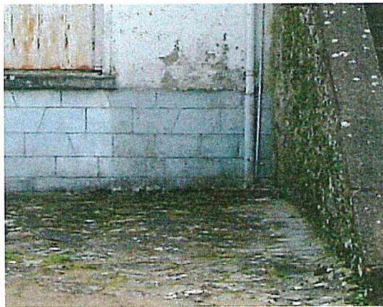
Problèmes d'humidité dus à l'enfermement du mur derrière un enduit ciment, à des zingueries non entretenues, à un drainage insuffisant des sols.
