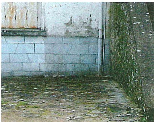
Problèmes d'humidité dus à l'enfermement du mur derrière un enduit ciment, à des zingeries non entretenues, à un drainage insuffisant des sols.
