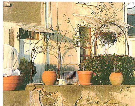
Mur de clôture en moellons nécessitant la réfection de son enduit.
