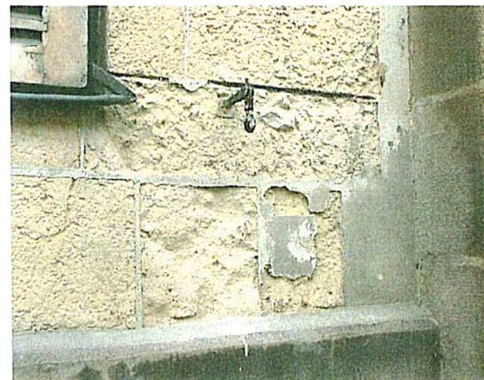
Dégradation du tuffeau due aux remontées d'humidité derrière un soubassement cimenté, et à des joints en ciment.
