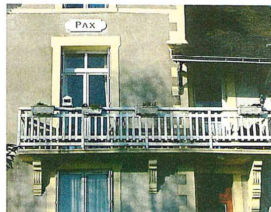
Décor à l'origine en pierre et en brique (malheureusement enduit) avec balcon en bois. Les menuiseries et le balcon pourraient être peints de couleur.
