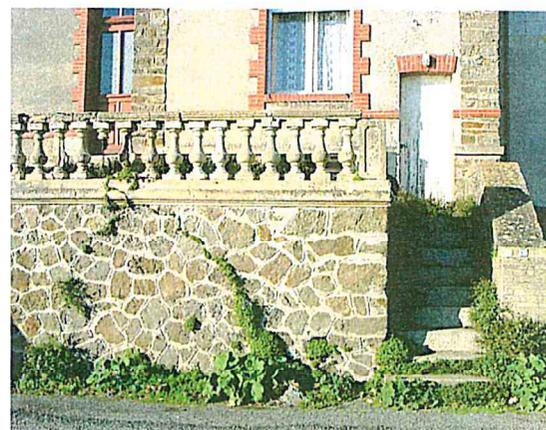
Mur de soutènement en pierre à balustrade. Pour ce mur, exceptionnellement, les moellons sont destinés à être vus, et ne doivent pas être enduits.
