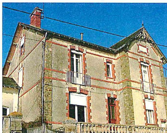
Villa du XIX<sup>e</sup> siècle en moellons enduits, avec décor de pilastres en pierre dure apparente, et décor de bandeaux et d'encadrements en brique et calcaire. Clôture à balustrade.
