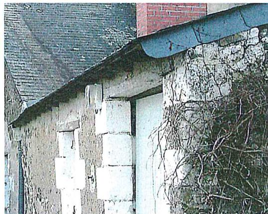
Toiture débordante sur bâtiment annexe. Protection de la rive de toiture par un rang d'ardoise. Sous-face de toiture non coffrée.
