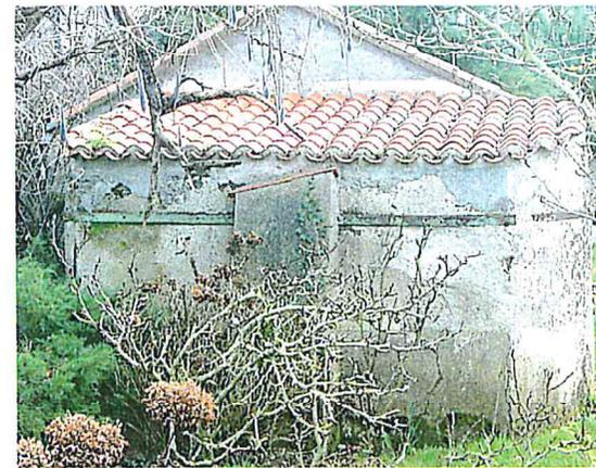
Maçonnerie de moellons réparée au ciment, qui devra être réenduite à la chaux et au sable.
