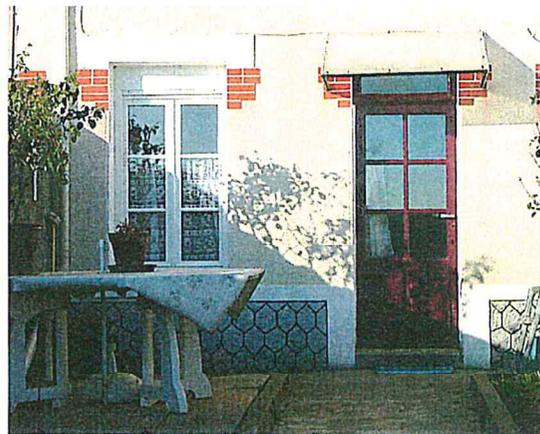
Fenêtre à 6 carreaux et porte vitrée du même dessin. Un lambrequin en bois découpé et peint pourrait cacher le coffre du volet roulant de la fenêtre.
