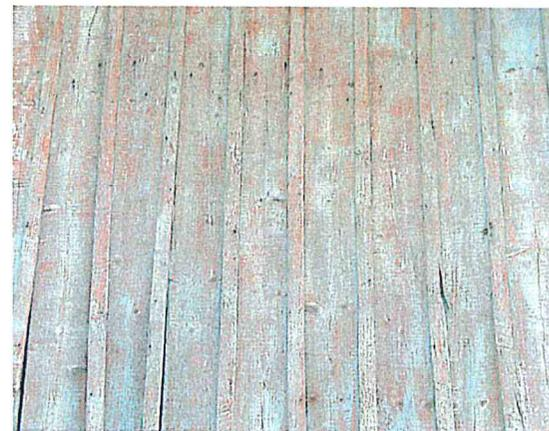
Détail de bardage de bâtiment annexe, en planches clouées avec joints en lattes plates.
