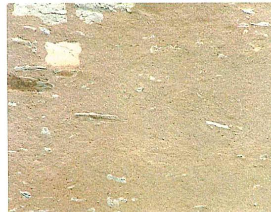
Enduit « à pierres vues », possible pour des pignons ou des murs de constructions annexes (hangars, granges, murs de clôture, etc.), mais à ne pas réaliser sur une façade de maison.
