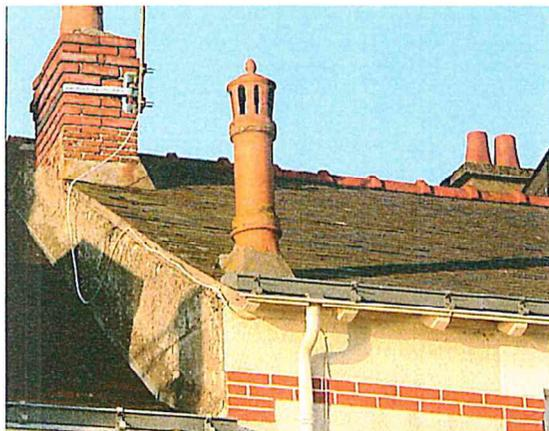
Toiture débordante avec dessous non coffré, faîtage en tuiles à emboîtements, mitron ajouré en terre cuite.
