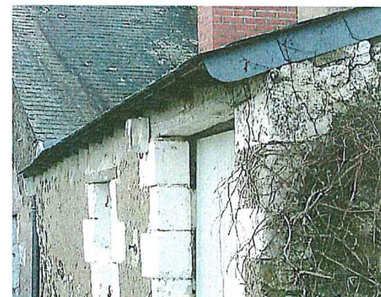
Toiture débordante sur annexe en appentis. Protection de la rive de toiture par un rang d'ardoise.
