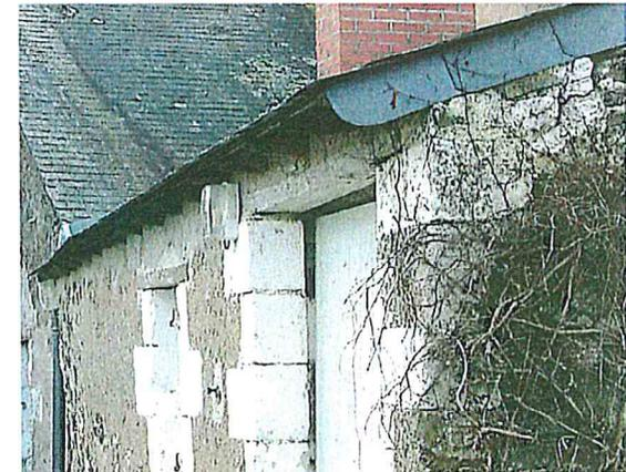
Toiture débordante sur annexe en appentis. Protection de la rive de toiture par un rang d'ardoise.
