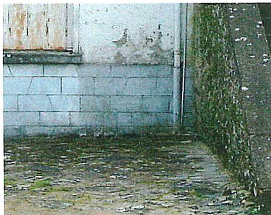
Problèmes d'humidité dus à l'enfermement du mur derrière un enduit ciment, à des zingueries non entretenues, à un drainage insuffisant des sols.
