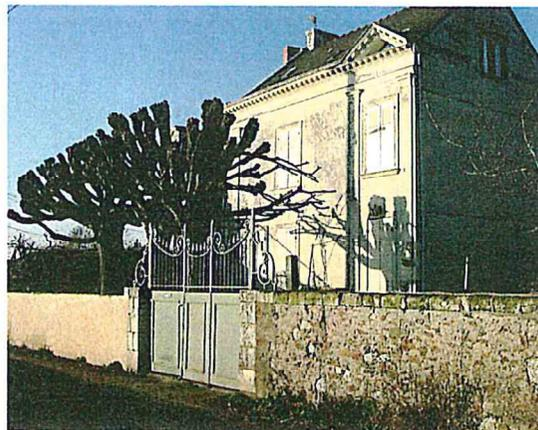
Mur de clôture partiellement restauré. L'enduit refait ne doit pas masquer les pierres de couverture du mur, ni les piliers du portail.
