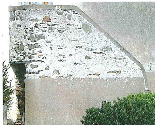
Maçonnerie de moellons ayant partiellement perdu son enduit, qui devra être réenduite.
