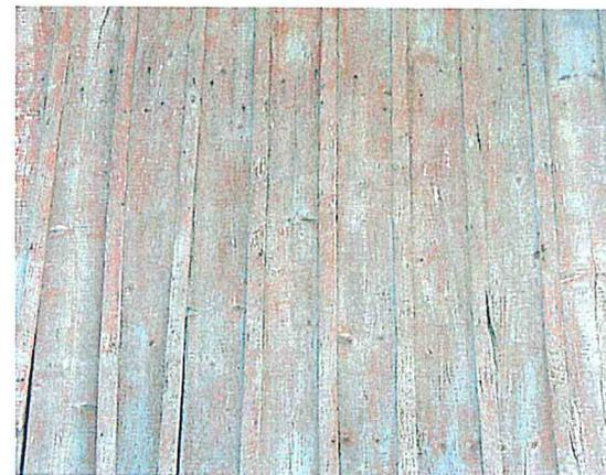
*Bardage de bâtiment annexe, en planches clouées avec joints en lattes plates.*
