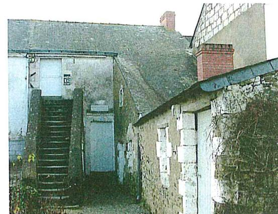
*Maison et annexes en moellons enduits et encadrements de tuffeau, menuiseries pleines en planches. Corniche sur le logis, débord de toiture sur l'appentis.*
