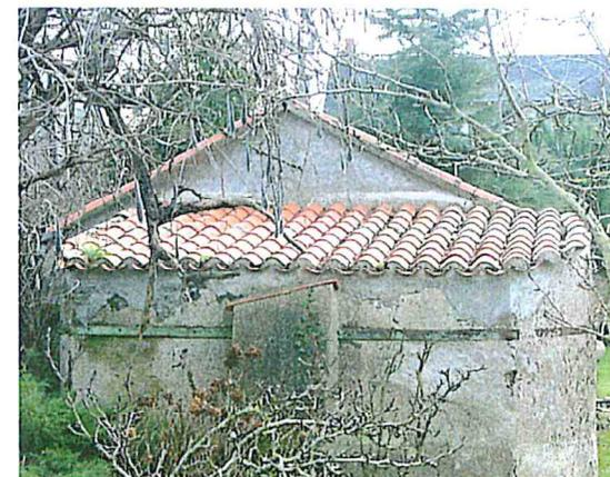
Exemple rare de toiture en tuiles sur un four de La Meilleraie. La tuile (ronde) doit être réservée aux bâtiments annexes dont les toitures ont une très faible pente.
