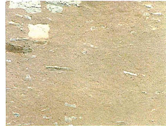
Enduit «à pierres vues», possible sur des pignons ou sur les murs de constructions annexes (appentis, murs de clôture, puits, etc.), mais à ne pas réaliser sur une façade de maison.
