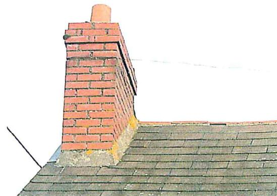
Exemples de souches de cheminées en brique, de teinte variable mais uniforme pour chaque souche. Les solins sont réalisés en mortier de chaux.
