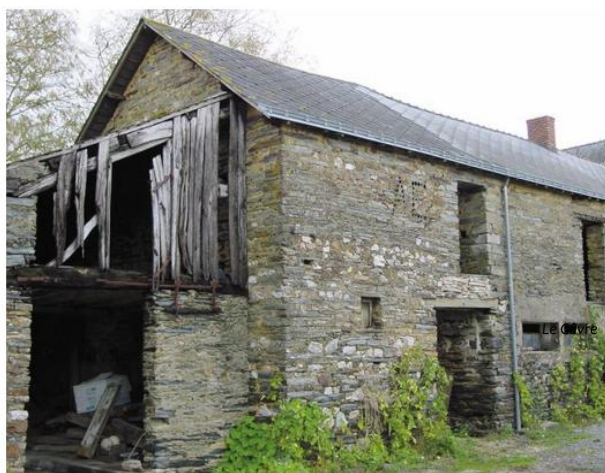
Le corps de ferme avant travaux
