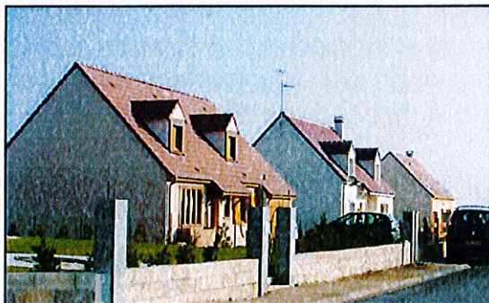
Figure 16 : habitations récentes sur la rue de la Grande Garenne
