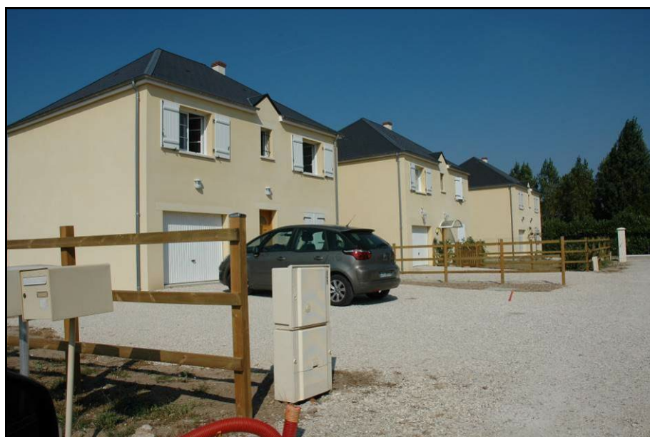
Constructions neuves rue de Limousins
