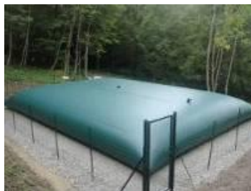
Figure 113 : Exemple de réserve incendie artificielle
