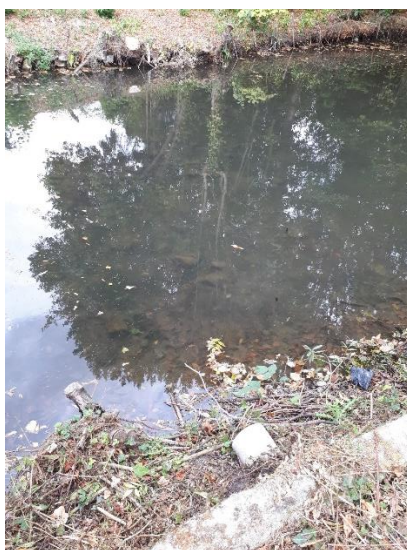
Figure 8 : Rejet du trop-plein du poste Moulin Davaut
