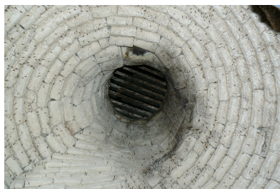
Four à chaux (détail)
