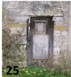
31 rue de Puiseaux Encadrement Porte
