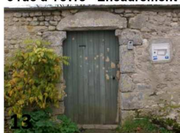
5 rue d'Yèvre - Encadrement
