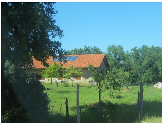
Réhabilitation des toitures et menuiseries à Malartic, © UrbaDoc 2014
