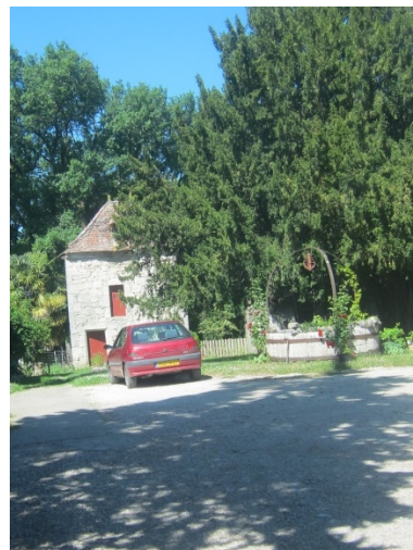
Puit et pigeonnier à Barrail, © UrbaDoc, 2014
