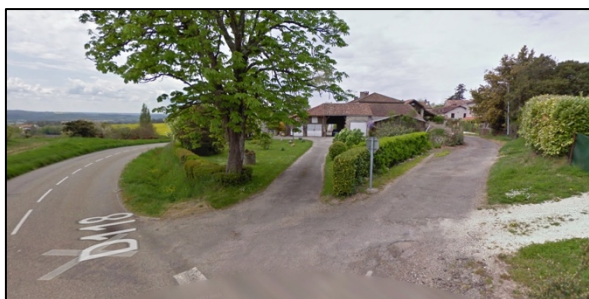
Débouché de la rue des Tisserands sur la RD 118 combinés avec des accès riverains : visibilité hasardeuse
