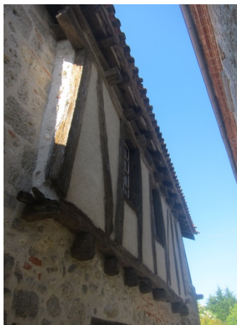
Eléments de constructions traditionnels, calcaire, pierre grise, bois, torchis, © UrbaDoc 2014
