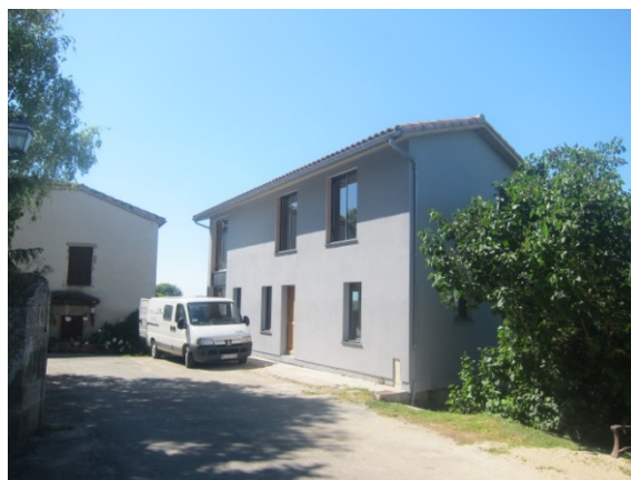
Transformation d'un séchoir à tabac en habitation, marge du château, © UrbaDoc 2014
