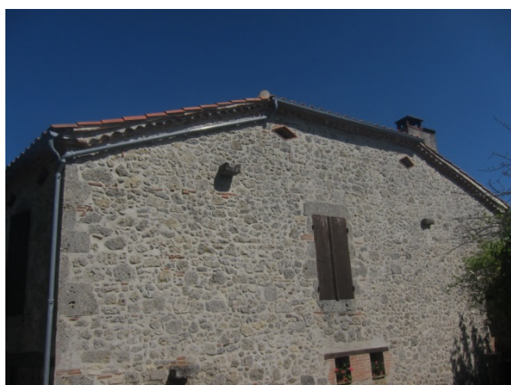
Façade laissée en pierre apparente, © UrbaDoc 2014
