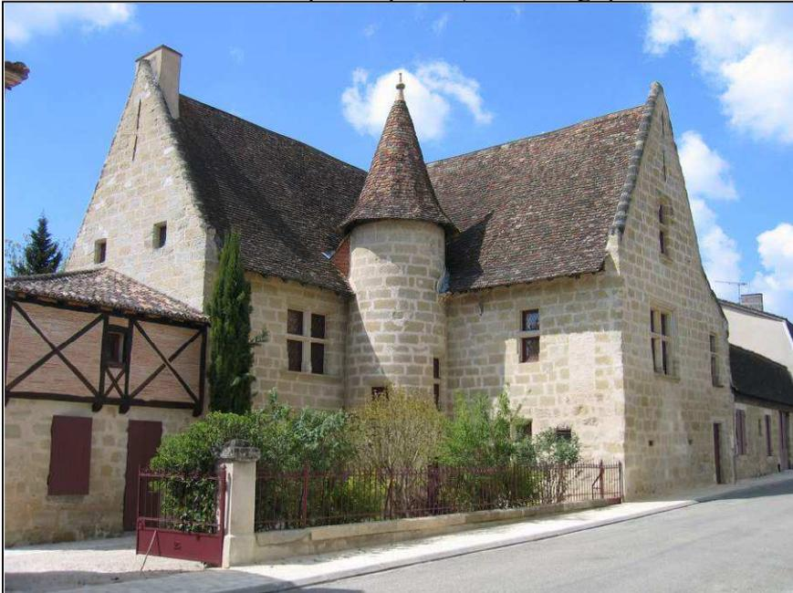
L'ardoise ainsi que la tuile de type canal sont utilisées le plus souvent comme matériau de recouvrement.
