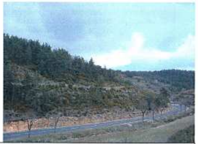
Colonisation spontanée d'un talus au-dessus de la RD 998
