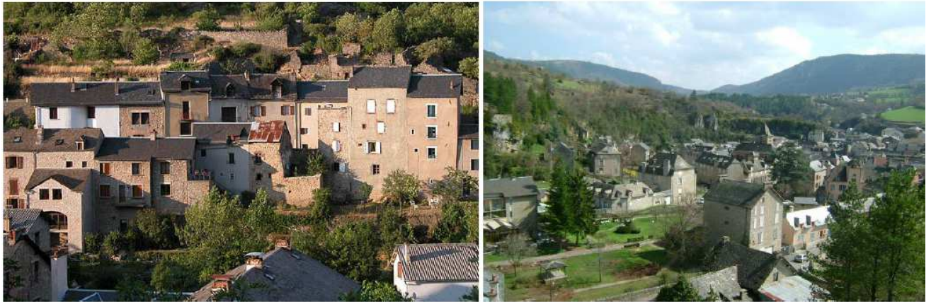
A la Canourgue, le bâti est parfaitement adapté à la pente
