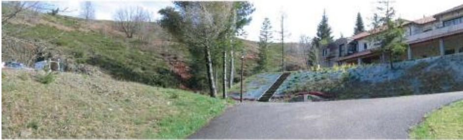
Centre de vie
