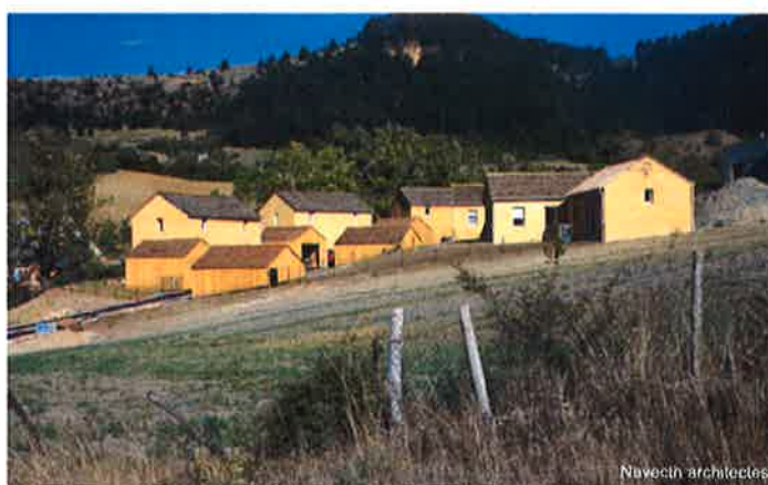
Lotissement les Terres Bleues, Lanuejols, Navecth architectes
