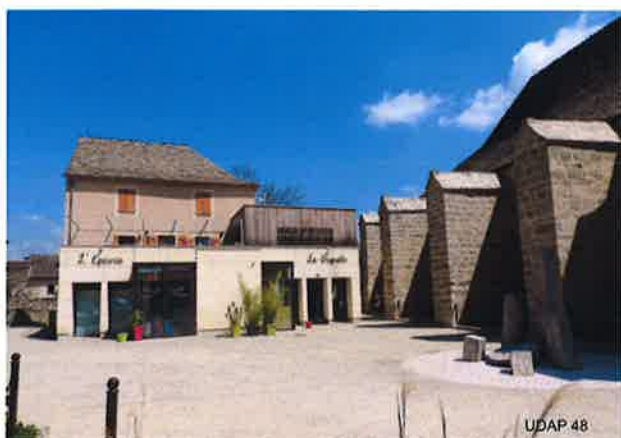
Extension pour logement et commerce, Bourgs sur Colagne, Le Monastier, Le Compas dans l'Oeil
