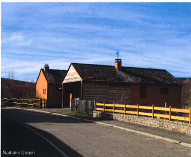
Maison individuelle, Nathalie Crépin architecte
