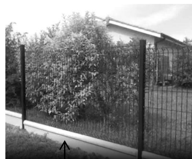
Plaque de béton en soubassement d'une clôture
