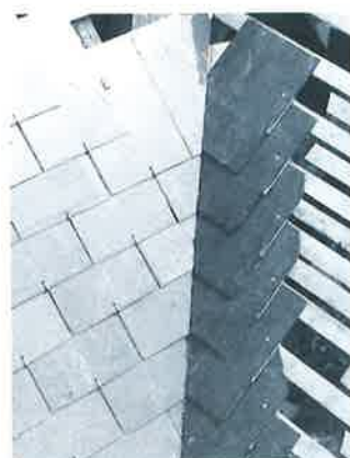
Noue fermée en zinc.
