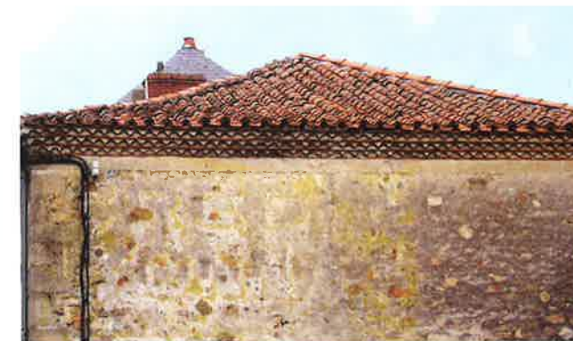
Toiture à croupes couverte en tuiles canal.
