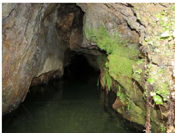
Photo 3 : Intérieur de la galerie au nord de la RD92
