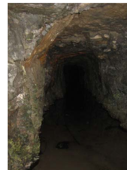
Photo 2 : Intérieur de la galerie à la Noiselette
