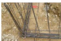
Nœud de chaînage - Continuité mécanique
