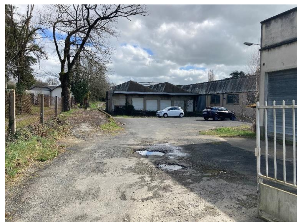
Photo 2. Vue sur l'accès au site
