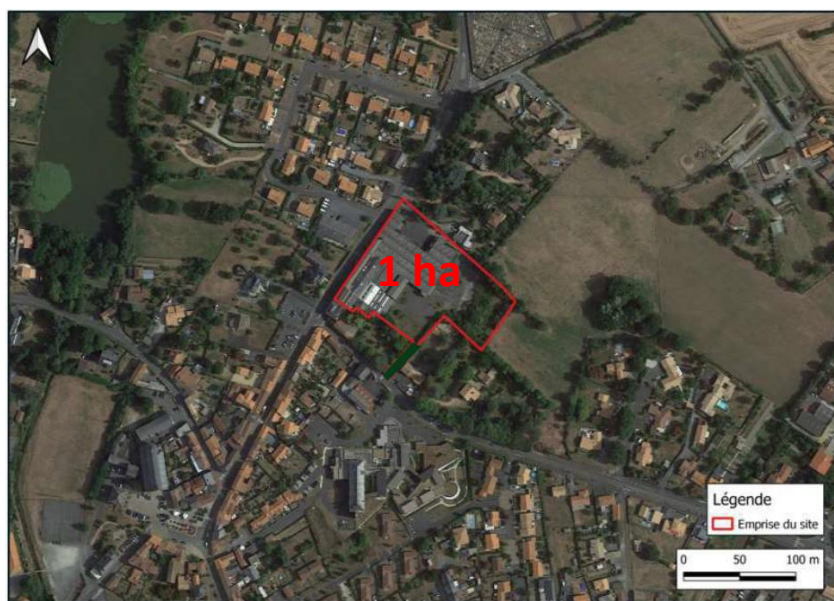
Emprise du site de l'ancienne usine de La Choletaise
