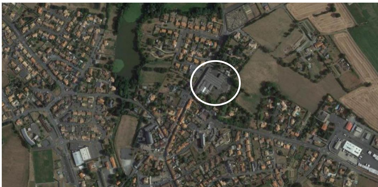
Carte 11. Localisation du site de La Choletaise dans le bourg de Saint-Germain-sur-Moine (rue du Dr. Raffegaue)
