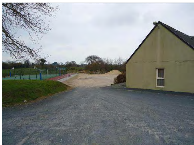
8 – Accès au parking de la salle polyvalente
