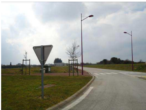
Zone d'activités en cours de réalisation
