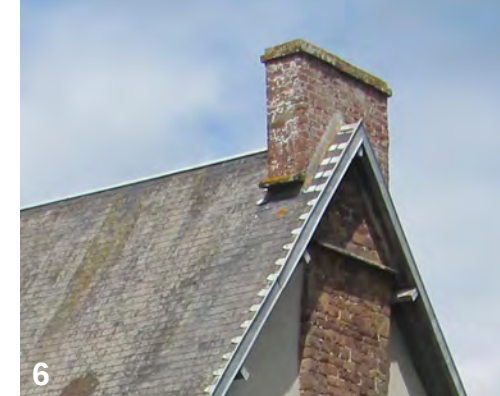
1. Toiture à croupe 2. Mur en diorite 3. Fenêtres à encadrement en pierre 4. Lucarne en bâtière 5. Lucarne à fronton 6. Souche de cheminée
