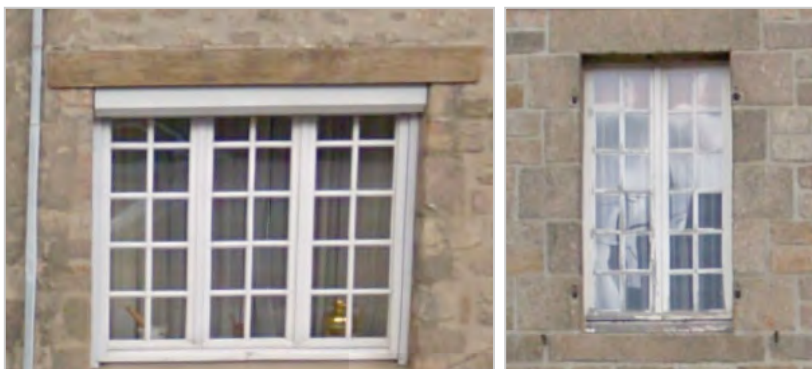
Exemples d'encadrements de baies (à gauche : linteau en bois / à droite : l'encadrement complet est en pierre de taille).
