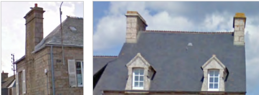
Cheminées implantées dans l'axe du faîtage
