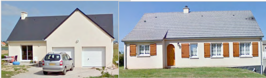
Exemples de constructions récentes sur la commune de Montfarville.
