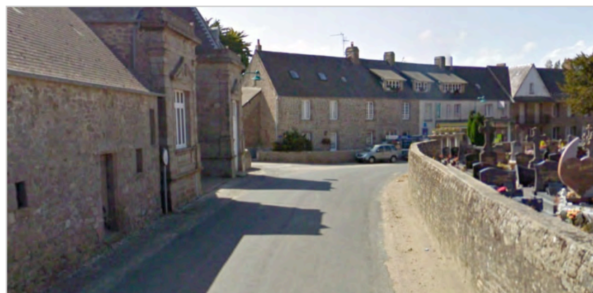
La rue des Hougues : l'espace public ne délimite pas clairement une zone de déplacement protégée pour la circulation piétonnière.
