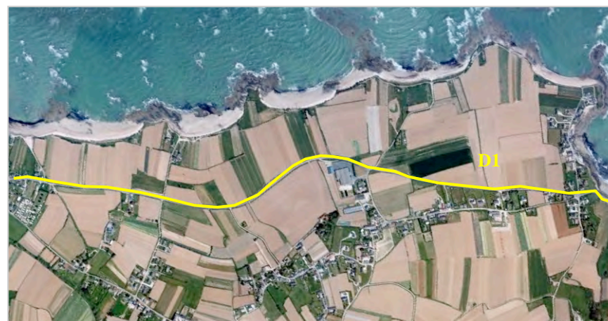
La D1 : un tracé qui offre des vues de grande qualité sur le domaine maritime.
