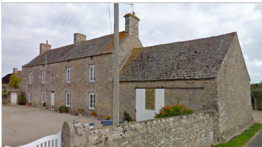
Des bâtiments qui se juxtaposent et renforcent le caractère du lieu (dessin issu de l'étude « Le bâti ancien du Cotentin » par le CAUE 50).
