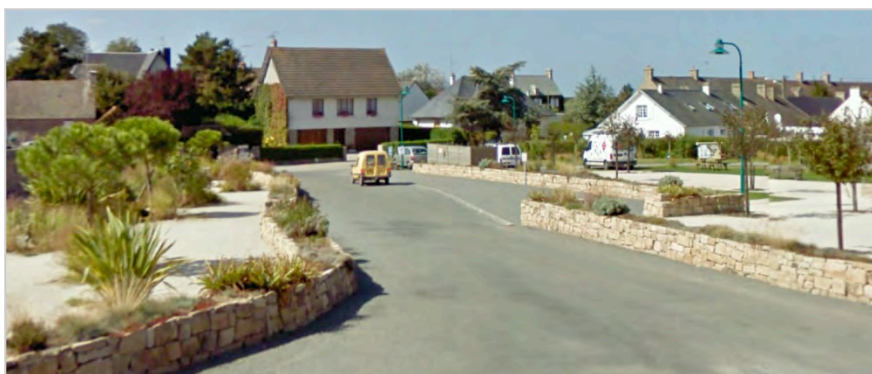
La place du 8 mai : un aménagement qui permet une structuration de l'espace public.
