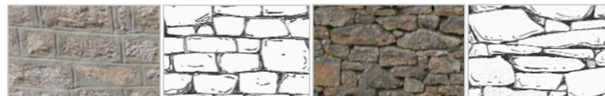
La pierre constitue le matériau de construction traditionnel du territoire, qu'elle soit en moellons (en haut) ou en pierres irrégulières (au-dessous).
